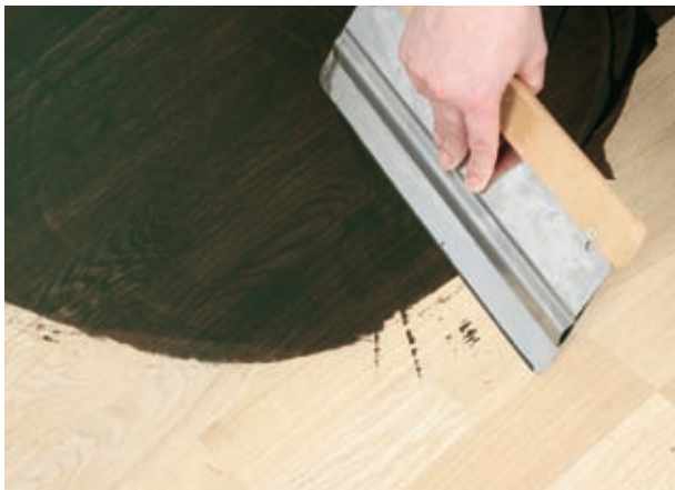
7) Utjevning av Osmo Color Oil med en stålsparkel
