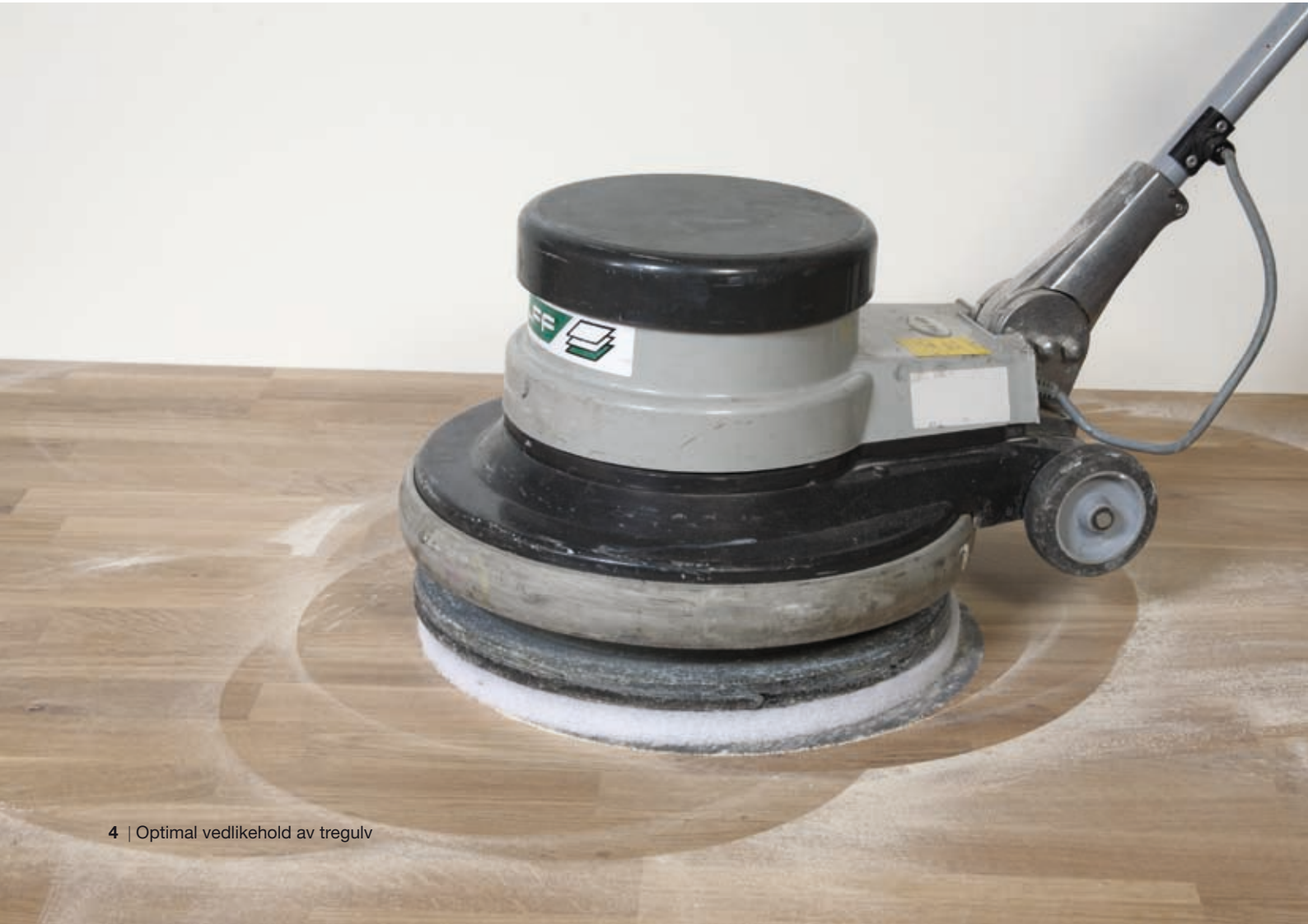
Sliping av et gulv med enpadsmaskin
