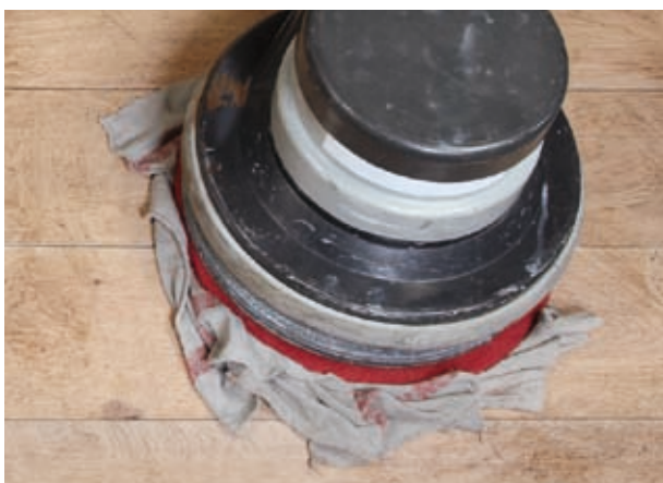
18) Fjerning av skitt etter rensing i figur 17
