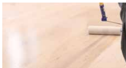
Påføring av lakk før tørking og herding starter.
